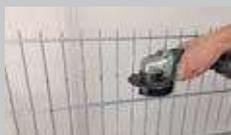
2. Öffnung mit einem geeigneten Werkzeug entlang der Markierung ausschneiden.
