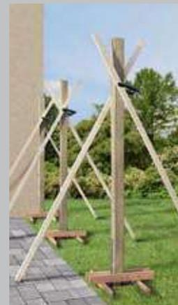
**3** Diagonale Latten helfen Ihnen, den Pfosten exakt in Höhe und Lot auszurichten. Fixieren Sie diese entweder mit einer Schraubzwinge oder mit Schrauben. Durch den Einsatz einer Spannschnur erreichen Sie, dass alle zu setzenden Pfosten in einer Flucht und gerade stehen. Anschließend füllen Sie das Fundamentloch mit Beton. Empfehlenswert ist B25 Fertigbeton, der vorab gründlich angerührt wird.
