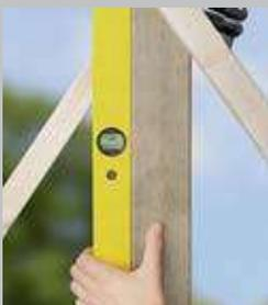
**4** Mit einer Wasserwaage kontrollieren Sie, ob die Pfosten im Lot stehen. Korrekturen sind solange möglich, bis der Beton abbindet. Achten Sie daher auf die angegebenen Fixierzeiten auf der Verpackung. Entfernen Sie die Stützen und Hilfsmittel erst nach dem Aushärten des Betons. Erst jetzt können Sie mit dem Anschrauben der Zaunelemente beginnen.
