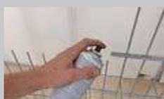
3. Versiegeln Sie die Schnittstellen – Korrosionsschutz!
