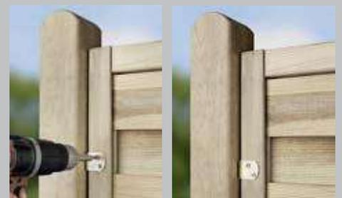
**6** Setzen Sie nun die Zaunelemente ein und fixieren diese, nachdem Sie die Schraublöcher vorgebohrt haben. Mit zwei Personen ist diese Arbeit, auch ohne Unterlegholz, einfacher zu meistern. Achten Sie auf den gleichmäßigen Pfosten-/Zaunelementabstand von 1 cm, eine gleichmäßige Höhe und die passende Flucht der Zaunfelder.
