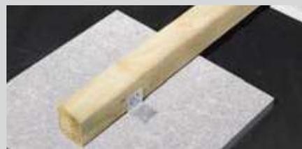
Jetzt wird die Unterkonstruktion hochkant und mittig auf den Platten verlegt und mit Metallwinkeln mindestens an drei Punkten daran befestigt. Nutzen Sie dafür einen Holz- bzw. für die Steinplatten einen Steinbohrer.
